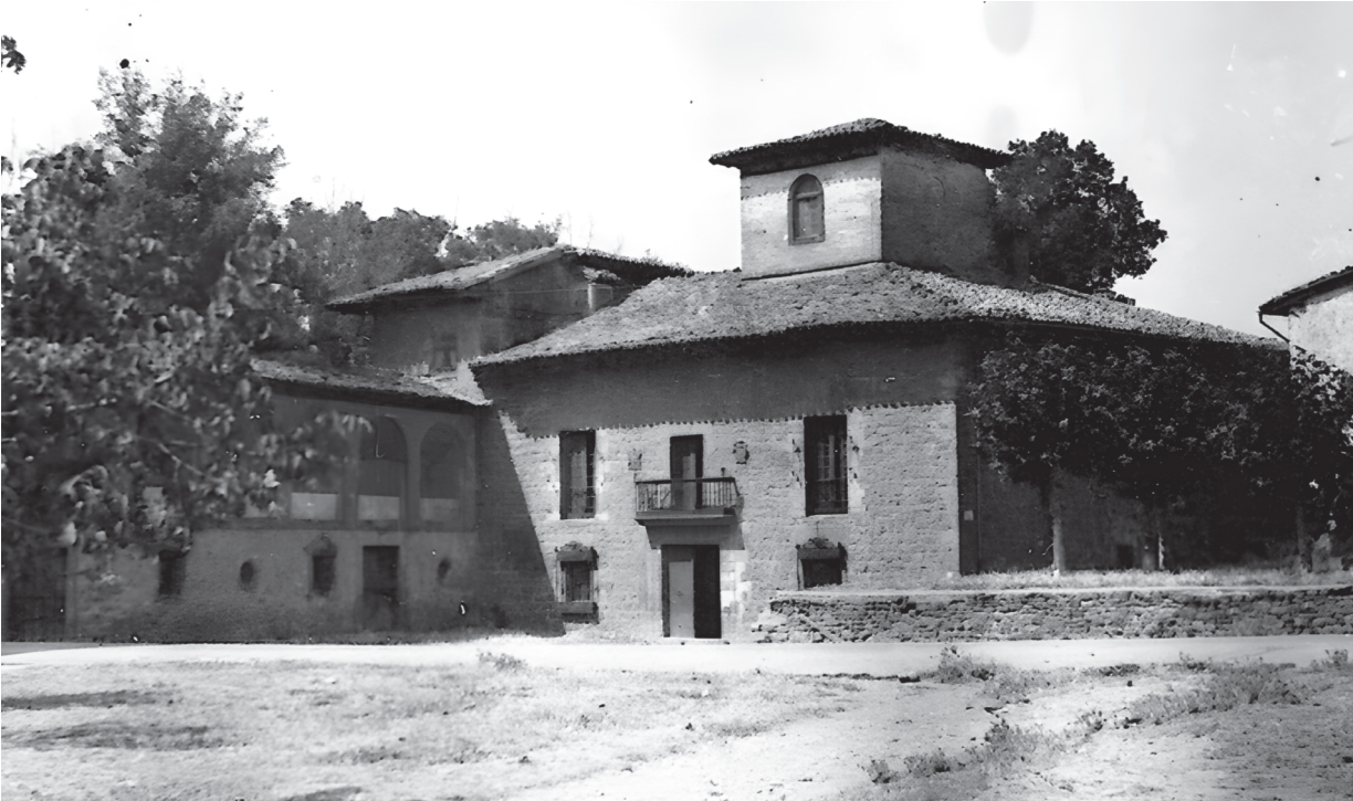
Dos vistas del Palacio de Argamasilla antes de la restauración.
