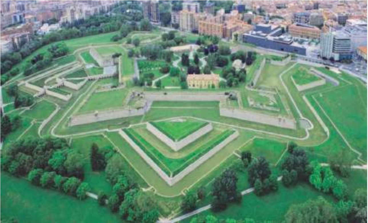
La Ciudadela de Pamplona tras la rehabilitación.
