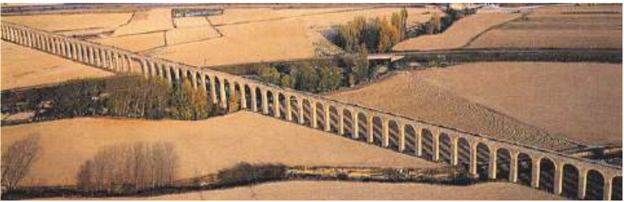
Acueducto de Noáin (Fotografía Enciclopedia de Navarra).
