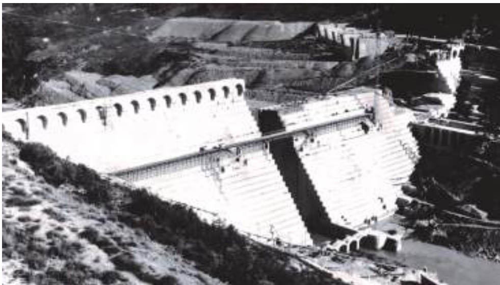
Presa de Yesa en construcción a mediados de los años 1950
