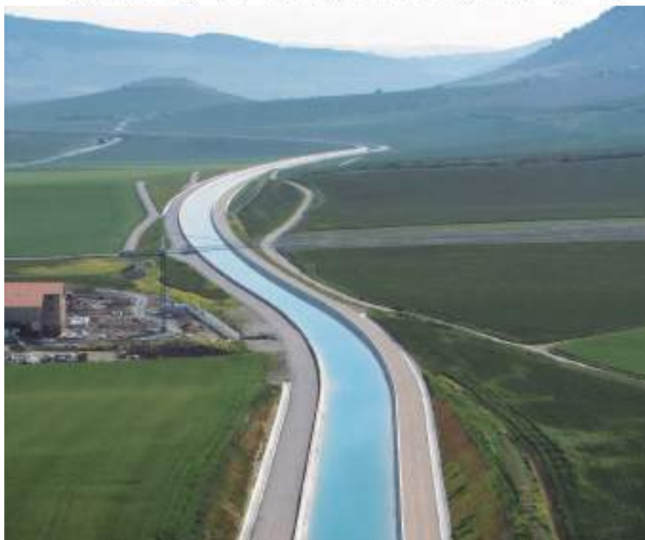
El Canal a su paso por Tiebas, y vista de la potabilizadora de la Mancomunidad de la Comarca de Pamplona.
