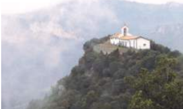
Vista general de la ermita.
