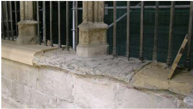
Reparaciones con piedra artificial.
