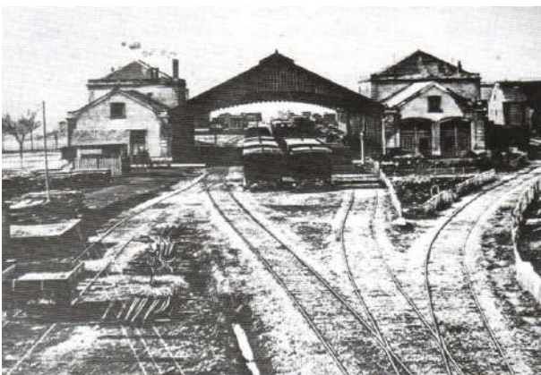
Estación Ferrocarril de Pamplona hacia 1885.
