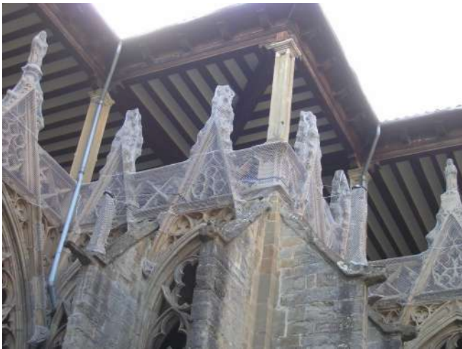
Foto 3. Durante los estudios previos se realizaron actuaciones de urgencia como la colocación de redes de contención en el sobreclaustro y tensores en los pináculos. Fotografía Gobierno de Navarra.
