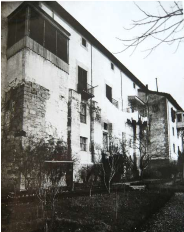
El edificio de Capitania, fue residencia de los virreyes desde 1539 hasta 1840. (Foto Julio Cía. Archivo Municipal).
